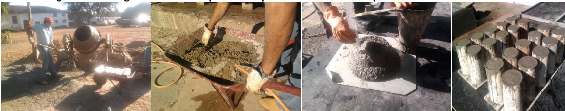
Figura 2: Moldagem do concreto produzido pelo setor de obras da prefeitura de Ilha Solteira-SP
