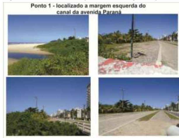
Figura 6: Início da revitalização da orla na região do ponto 1.
