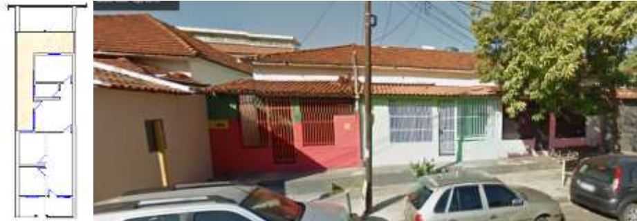
Figura 3: planta das casas geminadas dos ferroviários, à esquerda. Em destaque, vê-se o espaço livre da residência, destinado basicamente à circulação entre cômodos. À direita, foto dessa mesma tipologia de residência atualmente.
