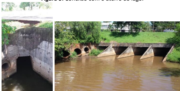
Figura 5: Conexão com o aterro do lago.
