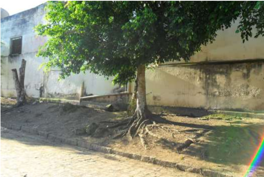
Figura 2: Observação de árvore com raízes expostas em calçada no município de Correntes-PE por adolescentes da rede pública municipal
